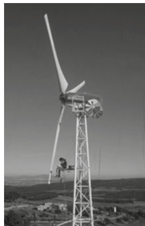
Famosa fotografia en què es veu un soci treballant el mecanisme per frenar les pales en cas d'un excés de velocitat del 12/15 a Vilopriu.
