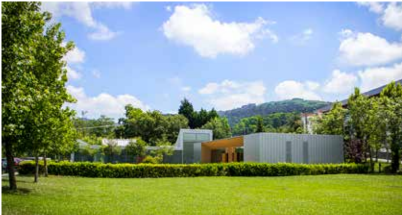
Vistas de edificios del Colegio Vizcaya.
